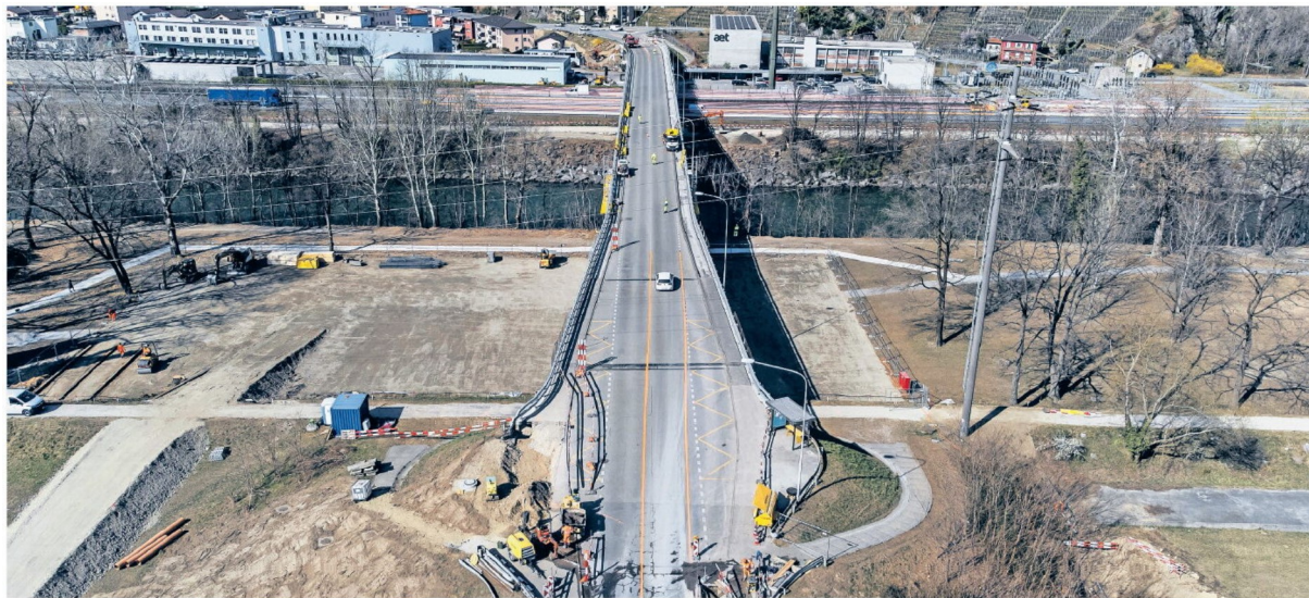
Lavori in corso nel comparto di via Tatti.
