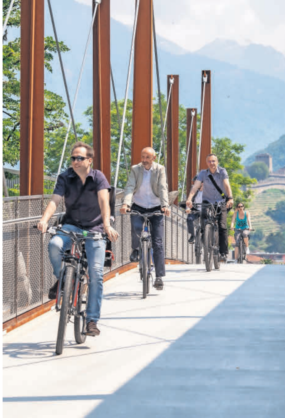
SUI PEDALI SENZA RISCHI L'opera garantisce la necessaria sicurezza agli amanti della mobilità lenta in un punto di forte traffico fra la capitale e Giubiasco. (Foto Reguzzi)
