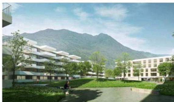
Sopra i sei edifici in costruzione (di PRESSO D'AGOSTA), sotto il rendering del progetto
